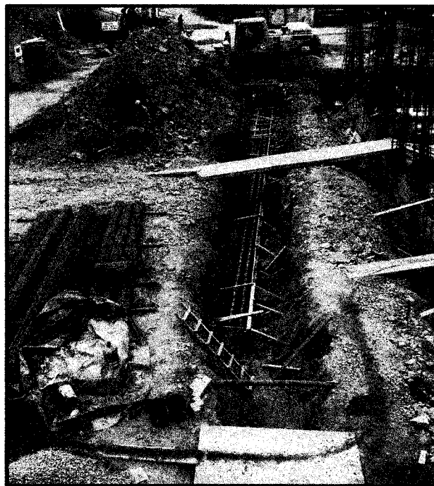
Encofrado de baja tensión
