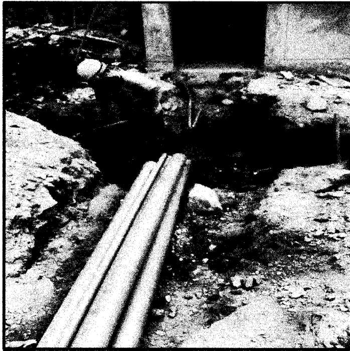
Colocación de tubería eléctricos
